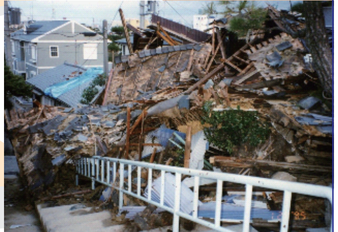
阪神淡路大震災 倒壊現場（平成7年1月21日撮影）
